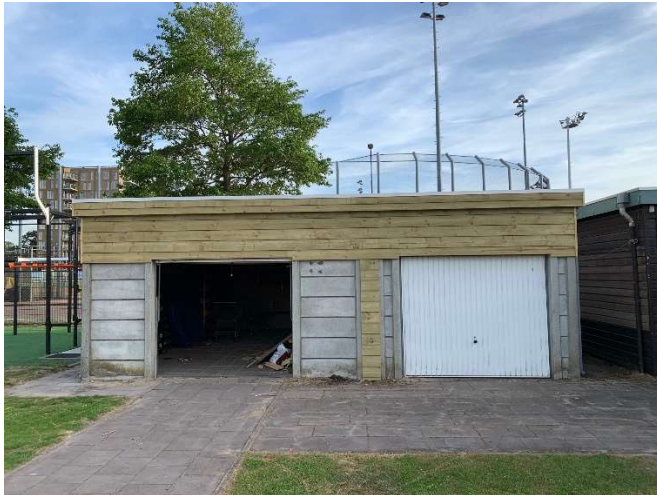
Foto: gezamenlijk materiaalhokken renovatie project 2022
